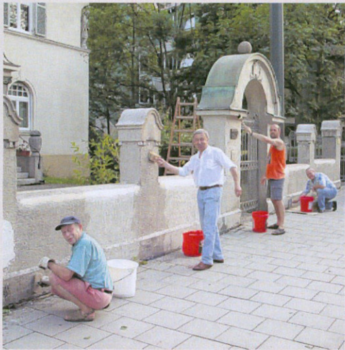
Neuer Anstrich für die Pfarrhausmauer.
