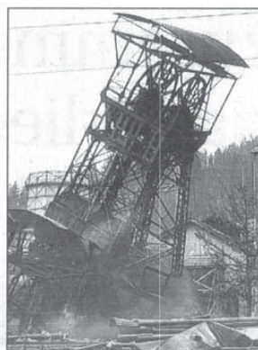
Die Sprengung des Turmes über dem Schoellerschacht nach der Schließung der Grube 1966.
