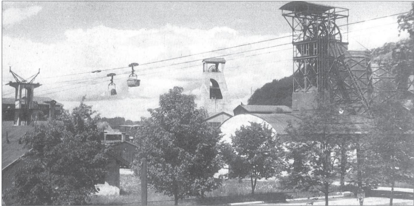
In Kübeln befördert eine Seilbahn die Abfälle vom Werk zum Tiefenbachgraben, vorbei an der Förderanlagen des Schöllers- (r.) und des Klenzeschachtes. Foto: Plettenberg
