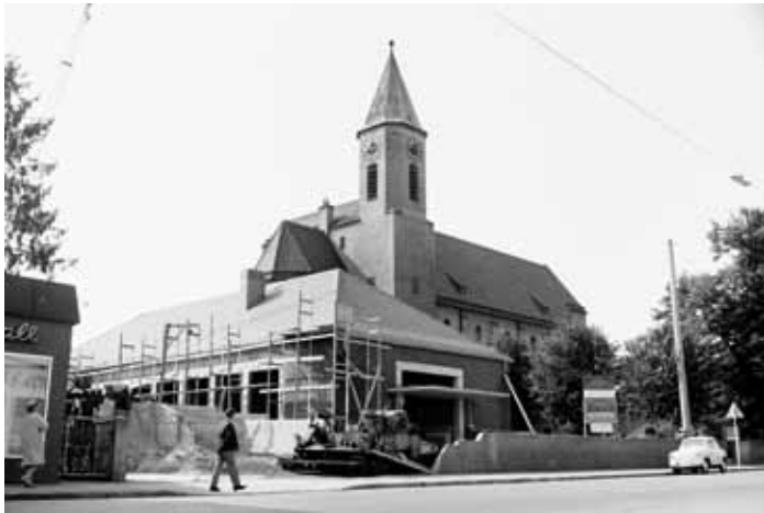
Errichtung des Pfarrheims 1965 (2170-Baustelle_Pfarrheim1965.jpg)
