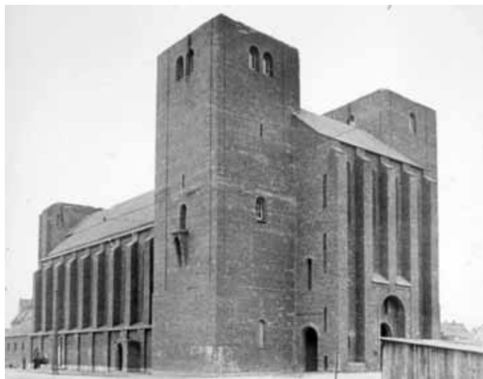
St. Thaddäus Rohbau 1941 (201-StThaddaeusnachBaustopp1941.jpg)
