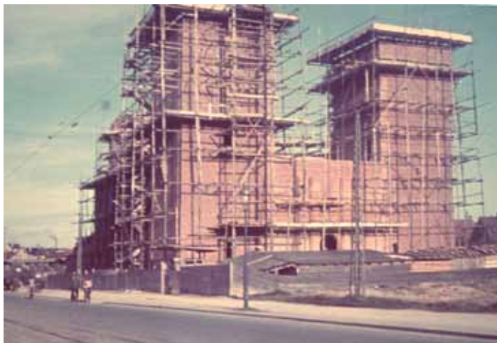
St. Thaddäus im Bau 1939 (KircheStThaddaeusUlmerStr1939a.jpg)
